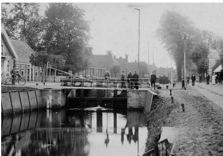
afb. 2. Het middelste verlaat te Nieuwe Pekela Foto S. Sanders en Zoon, Groningen, begin 20 e eeuw Coll. Kapiteinshuis Pekela.
