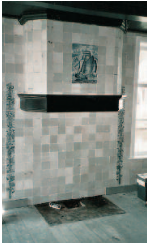
afb. 5 herstelde schouw met tableau en pilaartjes
